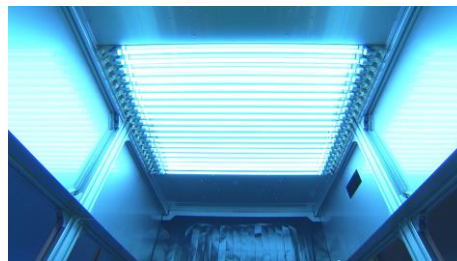
荷物コンベア用装置(内部)
