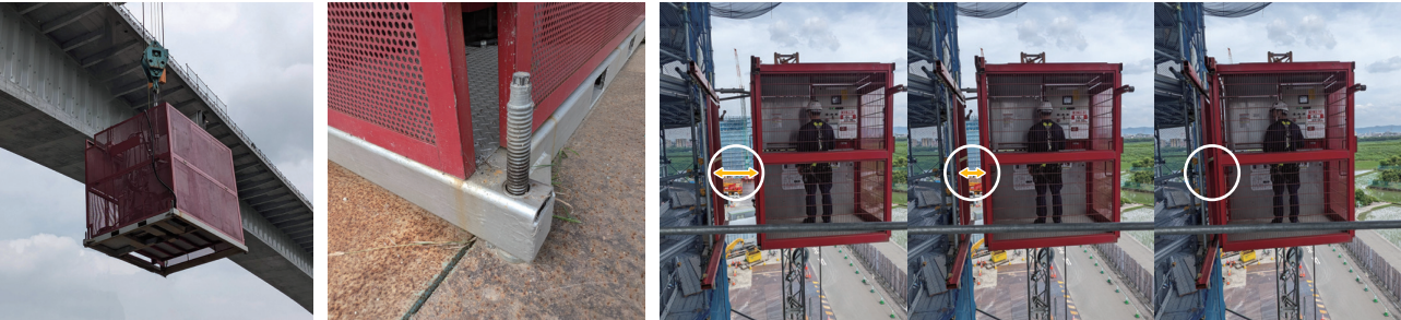
■ 下部ゲージ、昇降フレーム一括吊り ■ レベル出しジャッキ
